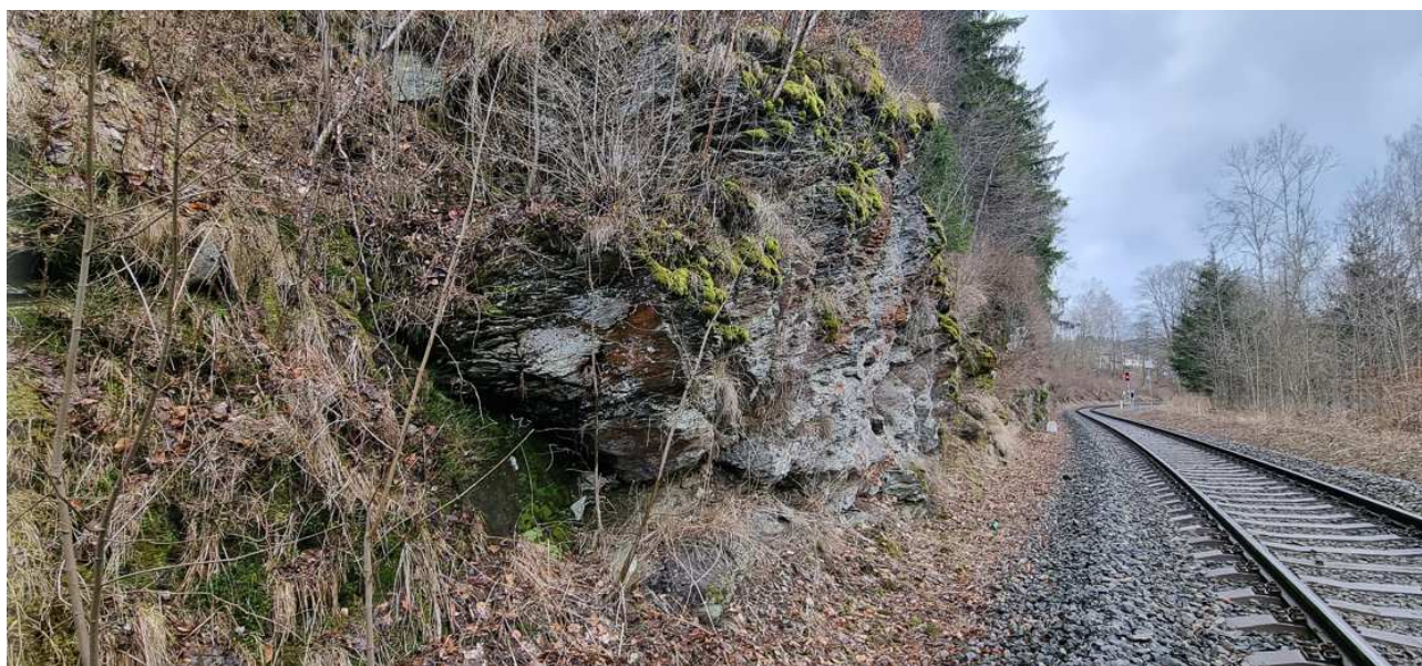
Pohled po směru staničení na oblast výrazného porušení v úvodní části úseku výlom nestabilních oblastí, odstranění vegetace, čistění skalní stěny, nesystémové kotvení, síťování, obnova akumulčního prostoru
