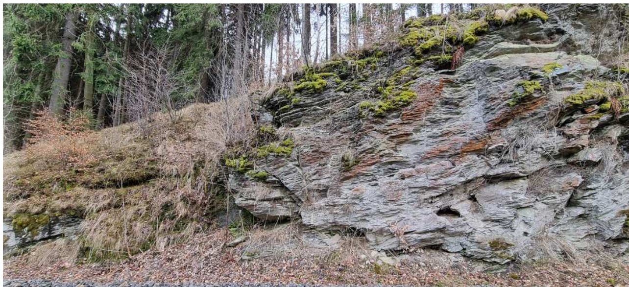
Pohled na oblast výrazného porušení v úvodní části úseku výlom nestabilních oblastí, odstranění vegetace, čistění skalní stěny, nesystémové kotvení, síťování, obnova akumulčního prostoru
